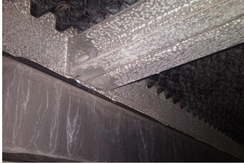
Şekil 1.9.Endüstriyel bir soğutma kulesi içi beyaz paslanmış profiller
