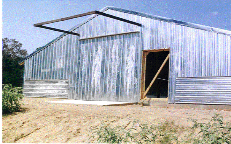
Şekil 1.8.Yüzeyinde Beyaz Pas oluşmuş bir baraka (Porter, F. C. 1994)
