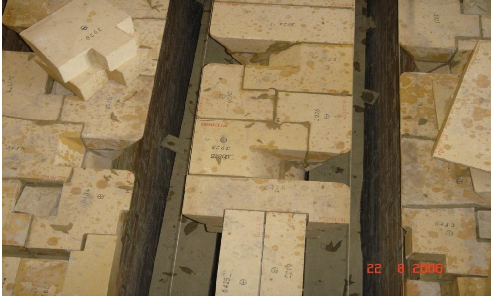
Şekil 4.7. Corbel Zone (Meyilli Yollar) Örümü
