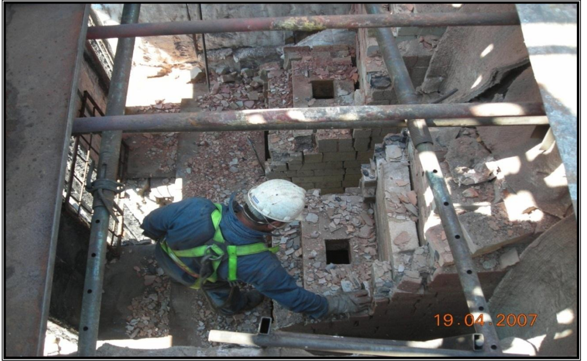
Şekil 4.21. Isıtma Duvarları Sökümü
