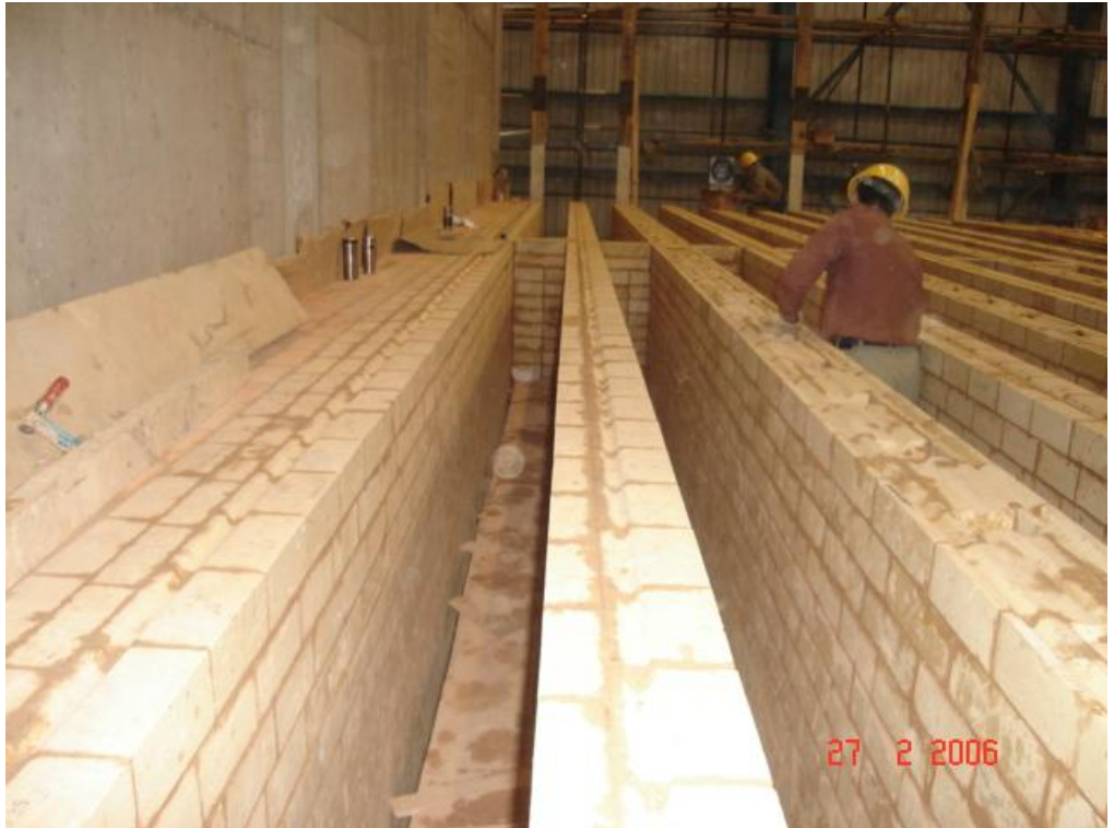
Şekil 4.4. Rejeneratör Duvarı örümü
