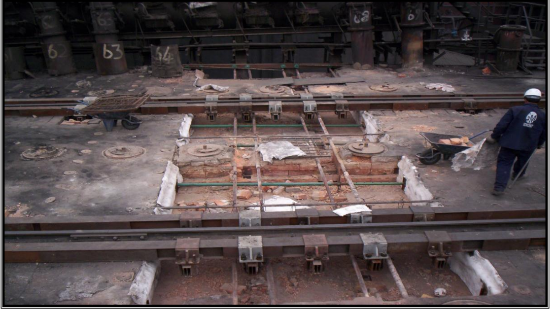
Şekil 4.20. Sıcak Tamir Fırın Çatı Bölgesi Sökümü
