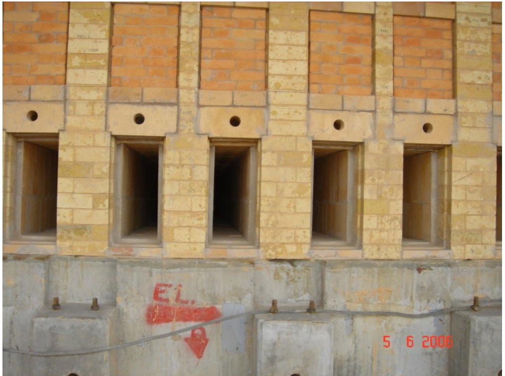
Şekil 4.3. Sole Flue Kanalları (Hava Gaz Kutusu Bağlantısı)
