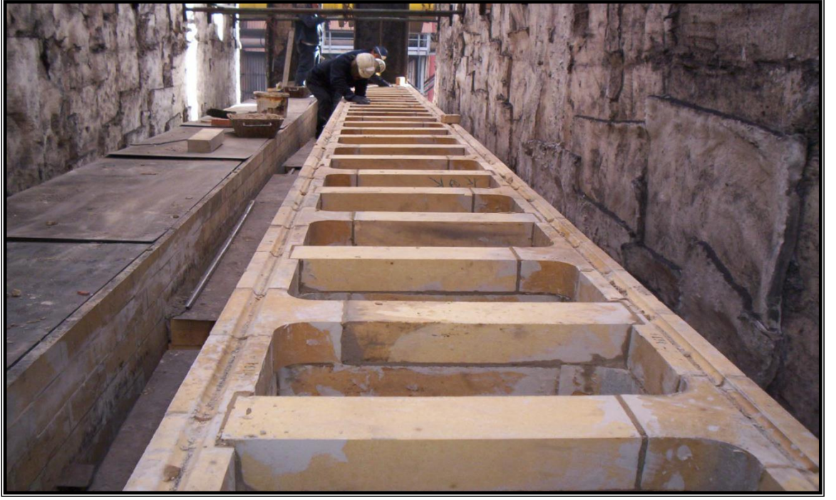
Şekil 4.22. Isıtma Duvarları Örümü
