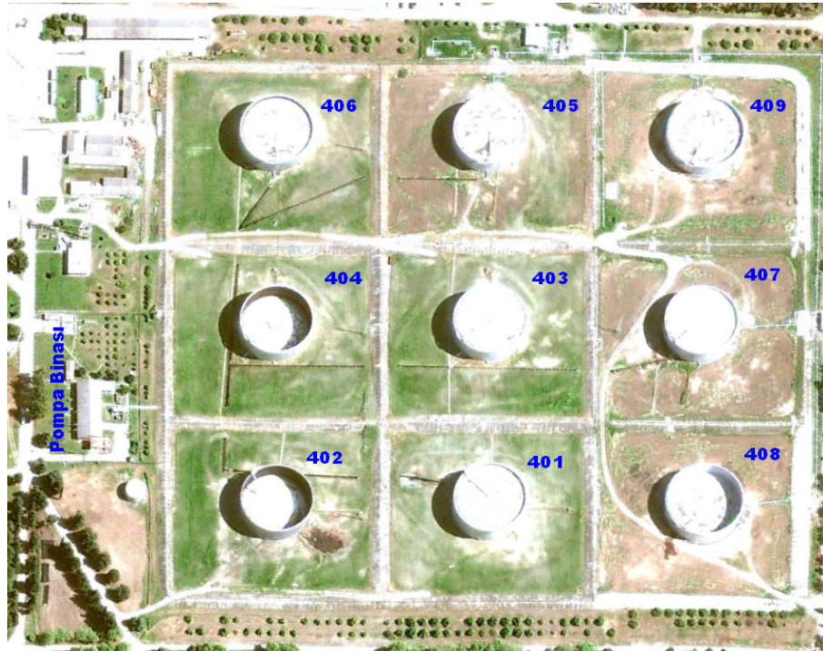
Şekil 3.4. Tank Sahası ve Pompa Binasının Mevcut Durumu (Google Earth,2011)
