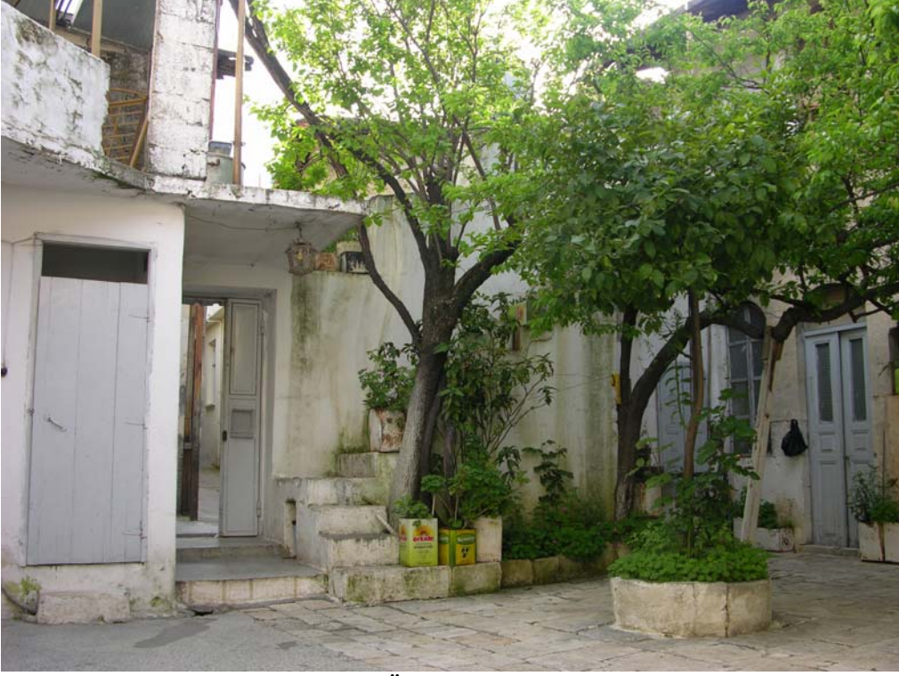
Şekil 4.8.5. Taş Döşemeli Zemin Üzerine Beton Dökülmüştür (Orijinal, 2005)
