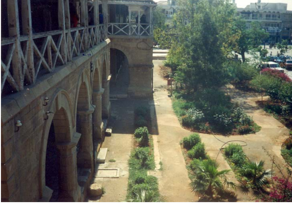
Şekil 4.8.29. Lefkoşe, Mahkeme Binası Avlusu (ORJİNAL, 2005)
