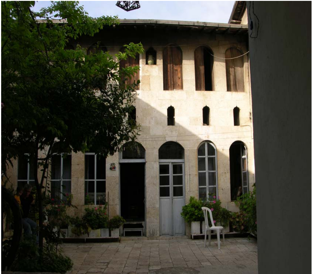
Şekil 4.8.11. Bakımlı Bir Eski Antakya Evi ve Avlusu (Orişinal, 2005)
