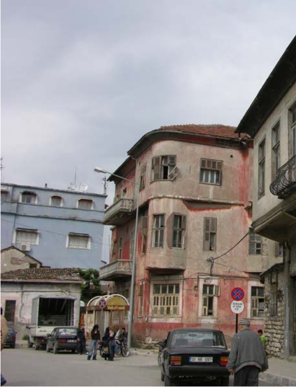
Şekil 4.8.15. Aynı Caddede Kamu Binası Olarak Kullanılabilir Bir Bina Örneği (Orijinal, 2005)
