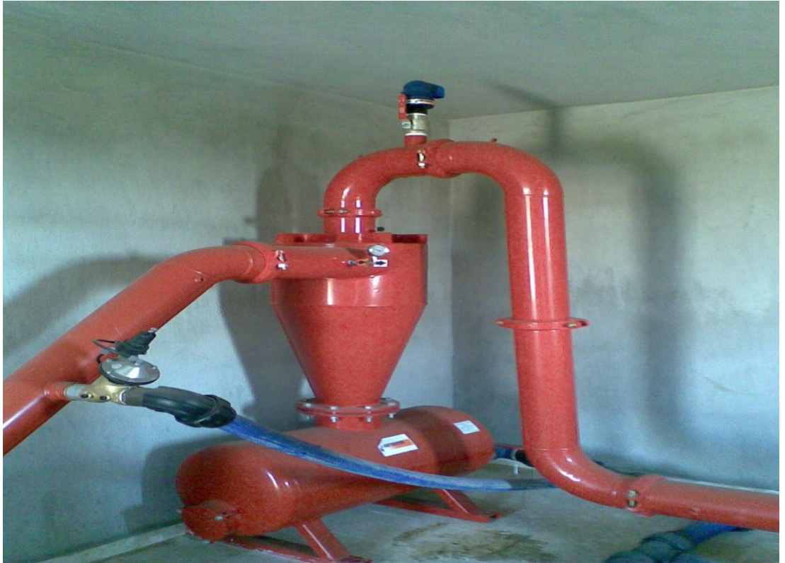
Şekil 3. 4. Denetim Biriminde Kullanılan Hidrosiklon Filtreden Bir Görünüş
