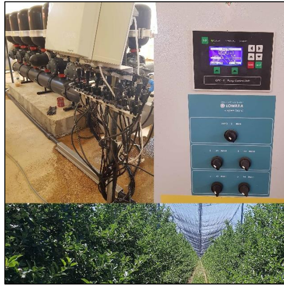
Şekil 3.8. Arazi sulaması ve gübrelemede kullanılan otomasyon sistemi
