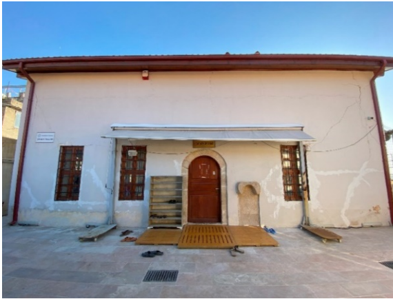
Fotoğraf 17: Harim giriş cephesi (Özkan, 2023)
