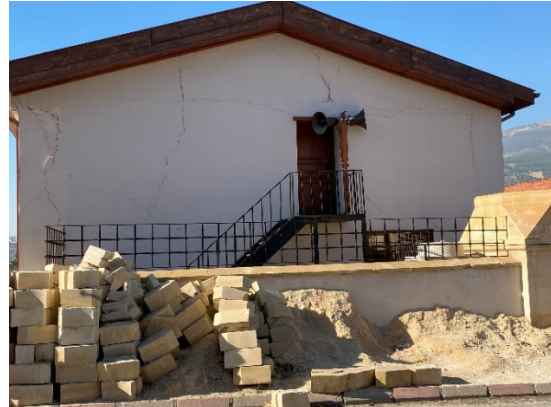
Fotoğraf 14: Cami doğu duvarına eklenen giriş (Özkan, 2023)
