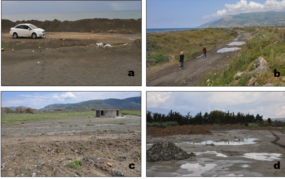
Foto 4: Eski kıyı kordonunun hemen gerisinde oluşturulan yapay kum-toprak seddesi ile denizel kumların kara içine ilerleyişinin engellenmesi (a, b) ve seddelerin arkasındaki alanların doldurularak, tarım alanına dönüştürülmesi (c, d).
