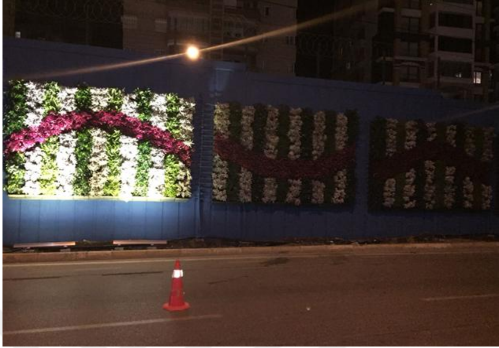
Şekil 4.38. Metro Hattı İstinat Duvarı Dikey Bahçe Uygulaması akşam görüntüsü (Adana Büyükşehir Park ve Bahçeler Müdürlüğü, 2018)
