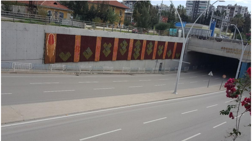
Şekil 4.20. Sular Alt Geçit ahşap desenlerle yapılan Dikey Bahçe Uygulaması (Orijinal, 2018)
