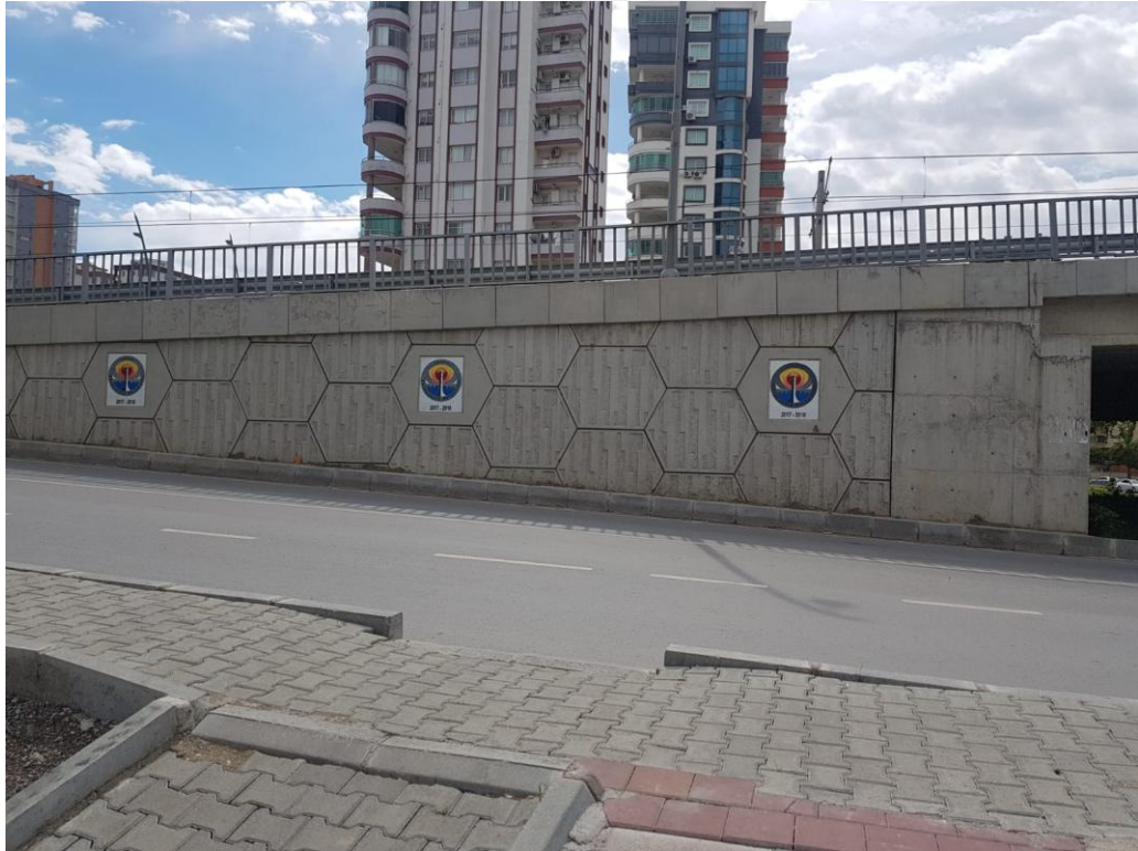
Şekil 4.9. Şehit Polis Ahmet – Mehmet Oruç İkizler Köprüsü Alt Geçit (Orijinal, 2018)
