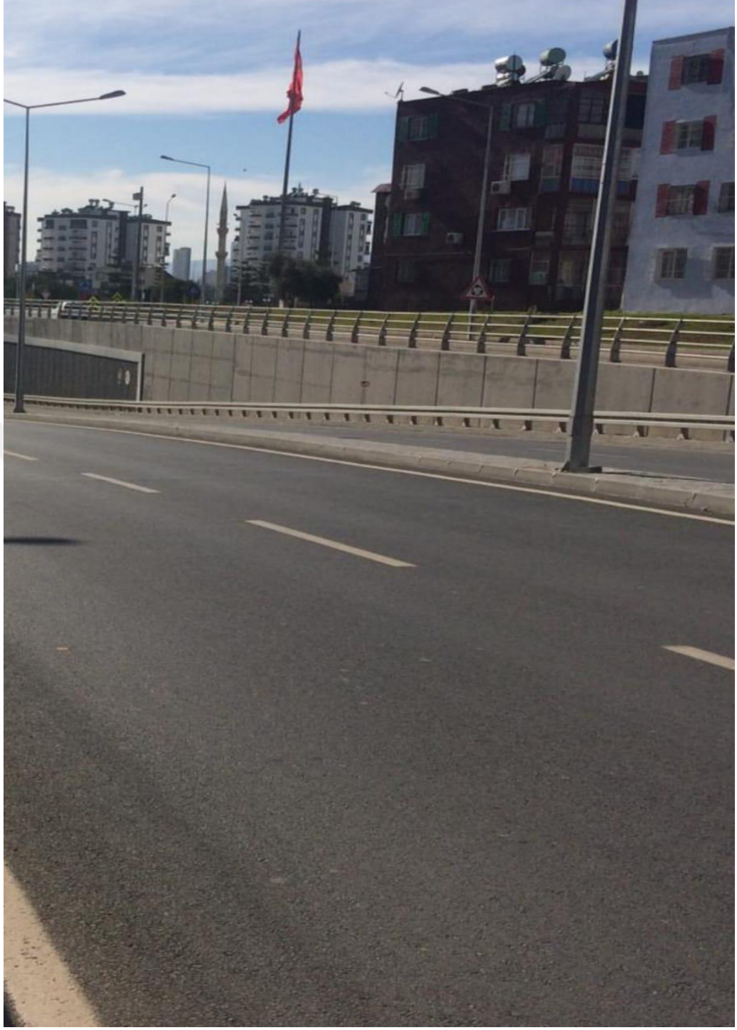
Şekil 4.49.3.Çevre Yolu Sonu Mezarlık Kavşağında Bulunan Alt Geçit (Orijinal, 2018)
