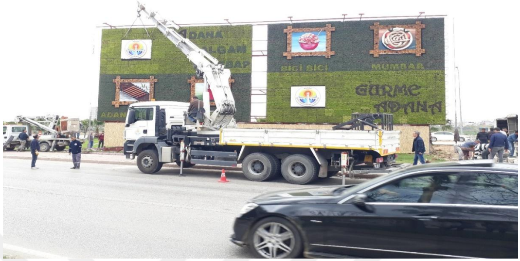
Şekil 4.26.Öğretmenler Bulvarı (Real Alışveriş Merkezi Yolu) Dikey Bahçe Uygulaması yapım aşaması 3 (Adana Büyükşehir Park ve Bahçeler Müdürlüğü, 2018)
