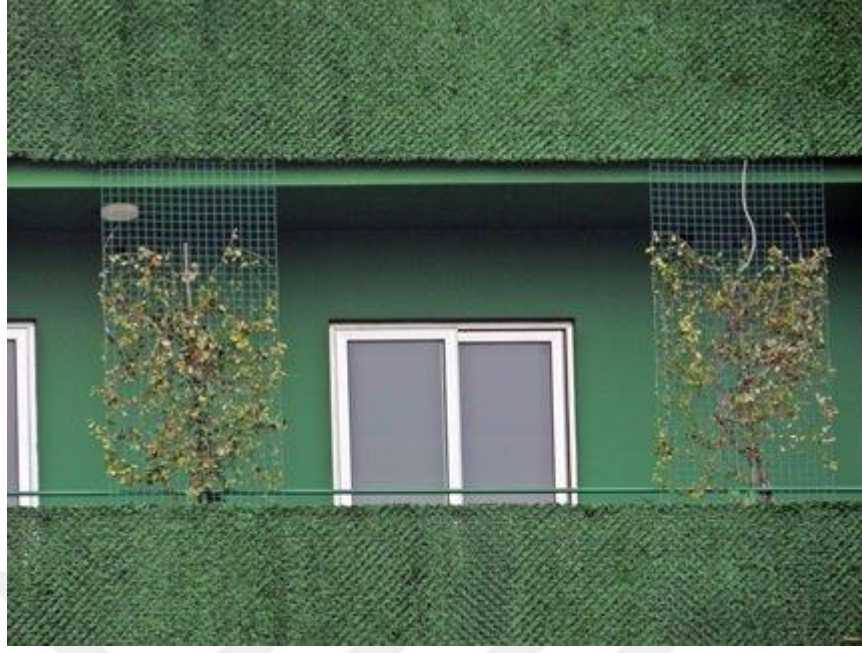
Şekil 4.46. Club Bahçe Dikey Bahçe Uygulaması 2 (Ersin Çaldır, 2014).
