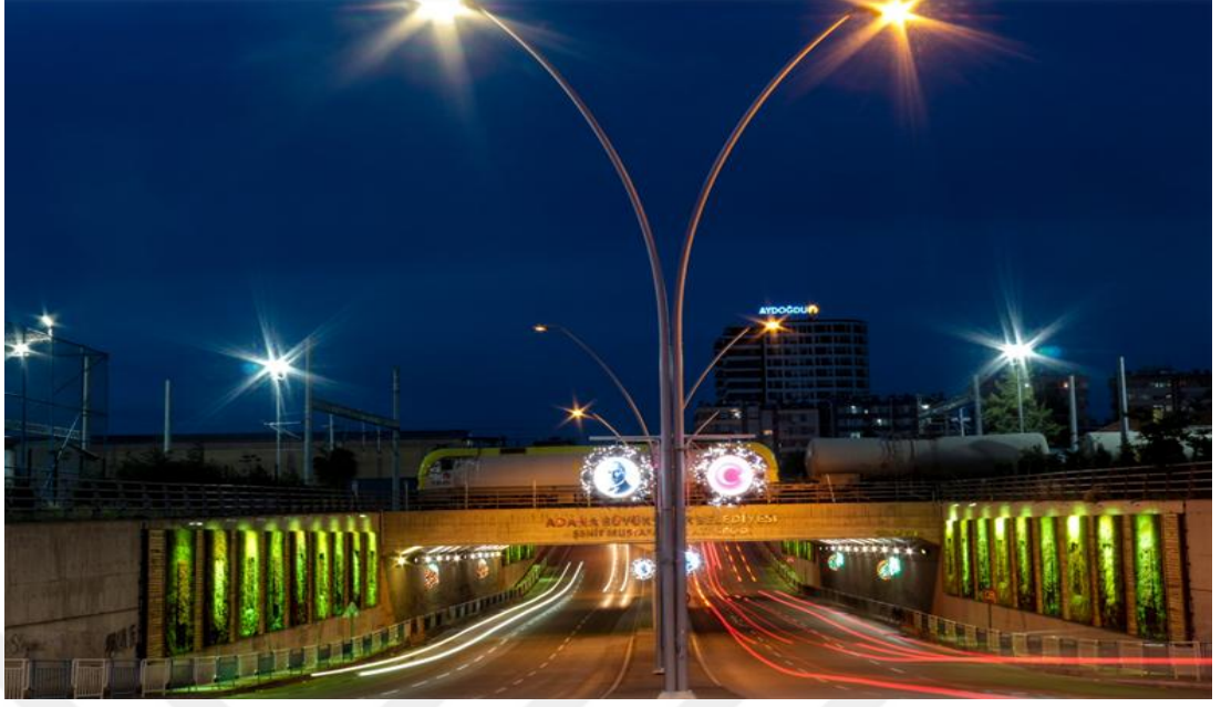
Şekil 4.23. Sular Alt Geçit ahşap desenlerle yapılan Dikey Bahçe Uygulaması akşam görüntüsü 2 (Adana Büyükşehir Belediyesi, Park ve Bahçeler Müdürlüğü, 2018)
