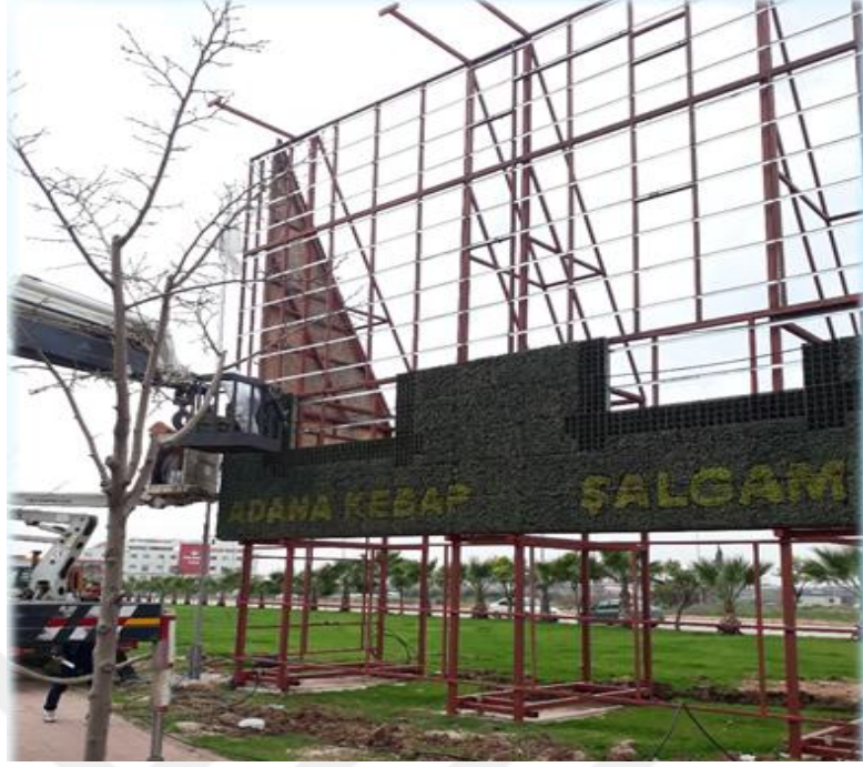
Şekil 4.24. Öğretmenler Bulvarı (Real Alışveriş Merkezi Yolu) Dikey Bahçe Uygulaması yapım aşaması 1 (Adana Büyükşehir Park ve Bahçeler Müdürlüğü, 2018)
