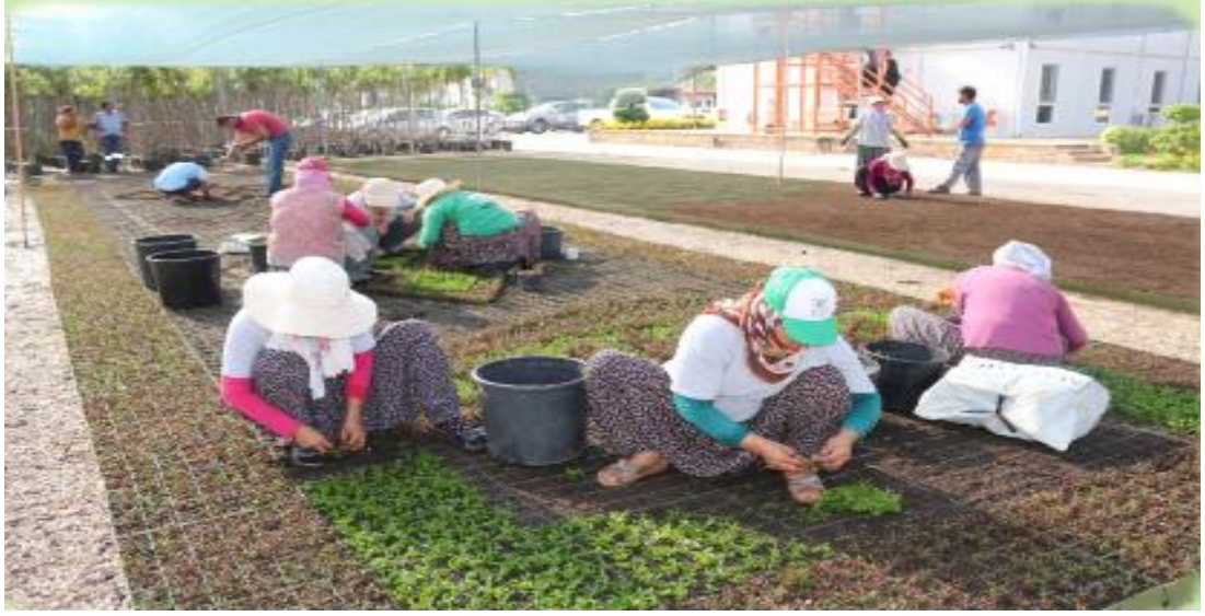
Şekil 4.17. Sular Alt Geçit Dikey Bahçe 2. Uygulama için Şantiyede Dikim Çalışması (Adana Büyükşehir Park ve Bahçeler Müdürlüğü, 2018)
