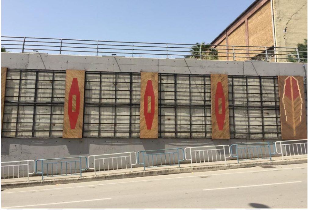
Şekil 4.19. Sular Alt Geçit ahşap desenlerle yapılan Dikey Bahçe Uygulaması Yapım Aşaması (Adana Büyükşehir Belediyesi, Park ve Bahçeler Müdürlüğü, 2018)
