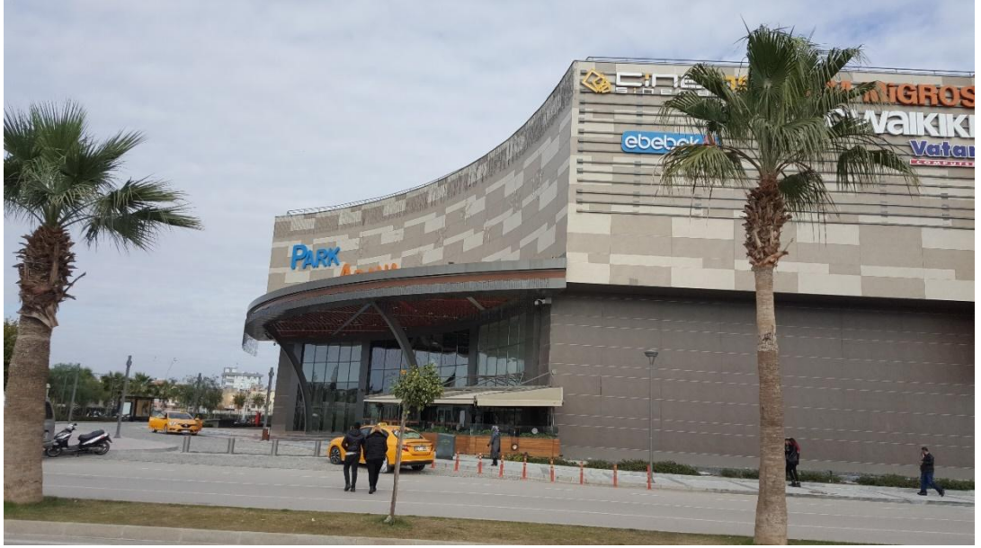
Şekil 4.13. Park Adana Avm Binası Duvarı (Orijinal, 2018)
