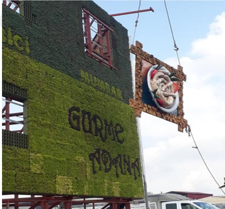
Şekil 4.25. Öğretmenler Bulvarı (Real Alışveriş Merkezi Yolu) Dikey Bahçe Uygulaması yapım aşaması 2 (Adana Büyükşehir Park ve Bahçeler Müdürlüğü, 2018)
