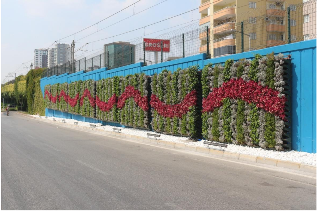
Şekil 4.37. Metro Hattı İstinat Duvarı Dikey Bahçe Uygulaması gündüz görüntüsü (Adana Büyükşehir Park ve Bahçeler Müdürlüğü, 2018)
