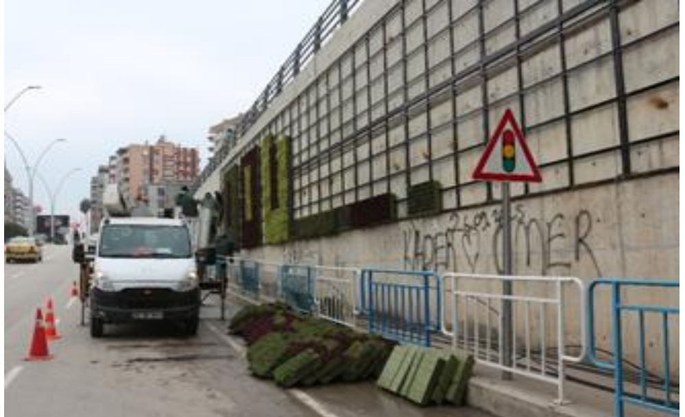
Şekil 4.16. Sular Alt Geçit Dikey Bahçe İlk Uygulaması devamı (Adana Büyükşehir Park ve Bahçeler Müdürlüğü, 2018)
