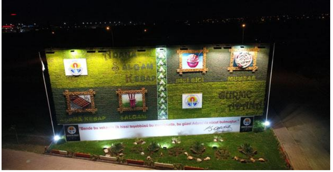
Şekil 4.28. Öğretmenler Bulvarı (Real Alışveriş Merkezi Yolu) Dikey Bahçe Uygulaması akşam görüntüsü (Adana Büyükşehir Park ve Bahçeler Müdürlüğü, 2018)
