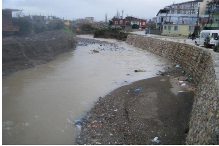
Foto 2. Kavaslı Deresi'nde aşırı yağışlar sonucu taşınan sedimentlerin akım azaldığında yatakta birikmesi (Resmin sol tarafında dere yatağının yeni aşınan kesimleri dikkati çekmektedir. Foto: Atilla KARATAŞ, Tarih 20.12.2009).
