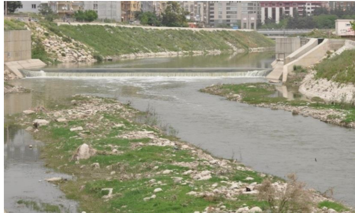
Foto 5. Asi Nehri'nde Yaz Mevsiminde Suların Çekildiği Dönemde Ortaya Çıkan Sedimentler (Yatak DSİ Tarafından Belirli Aralıklarla Temizlenmektedir).
