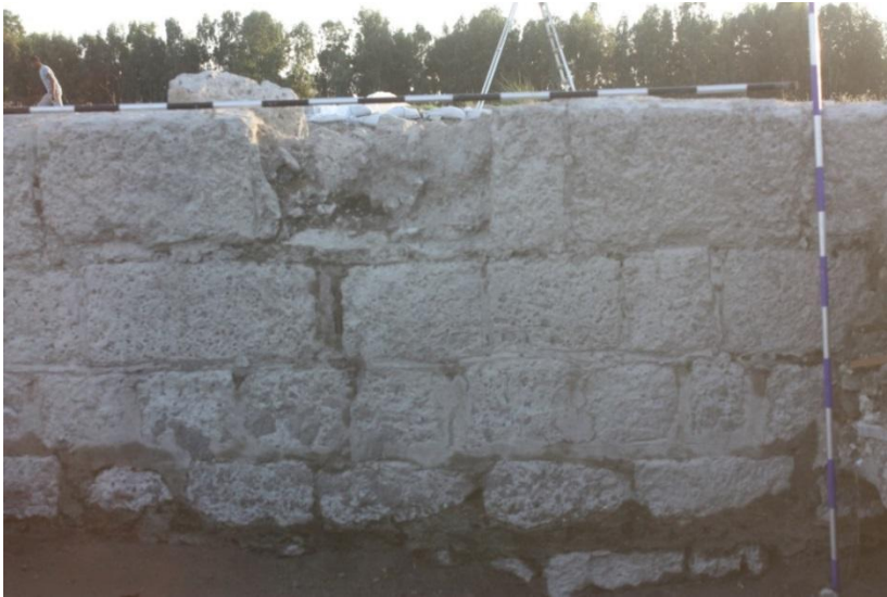
Resim 13: Kuzey duvarı, kullanılan taşlar.
