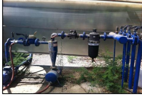
Şekil 3.4. Damla sulama sisteminin denetim birimleri
