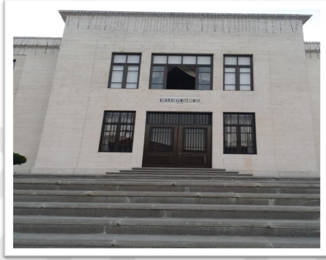
Şekil 3.11. Antakya belediye binası
