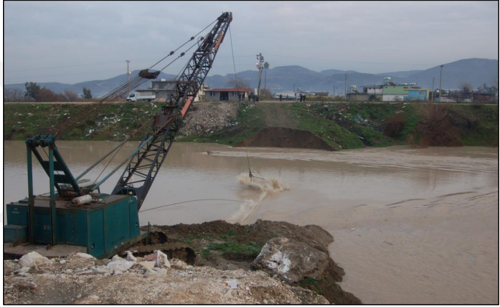
Şekil 4.4. Güzelburç civarında toprak bendin kaldırılması
