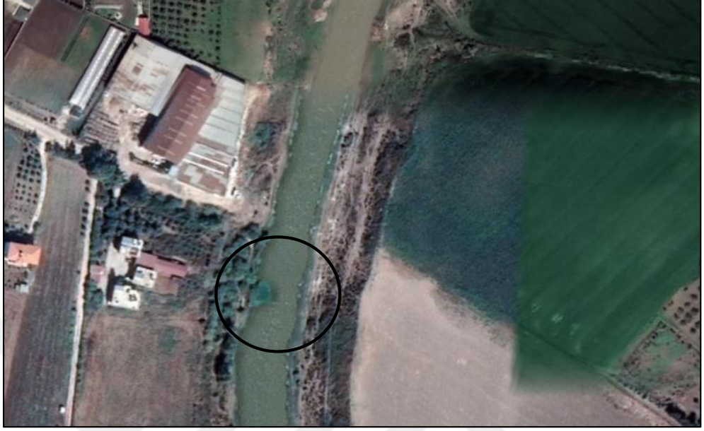
Şekil 4.37. On altı nolu istasyonda kanal kesiti daralması
