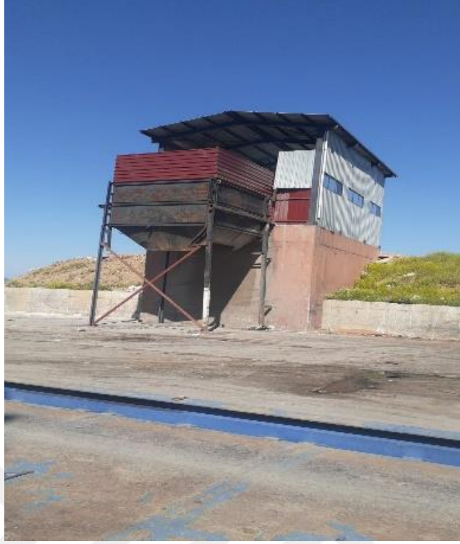
Şekil 4.11. Hassa katı atık aktarma istasyonu
