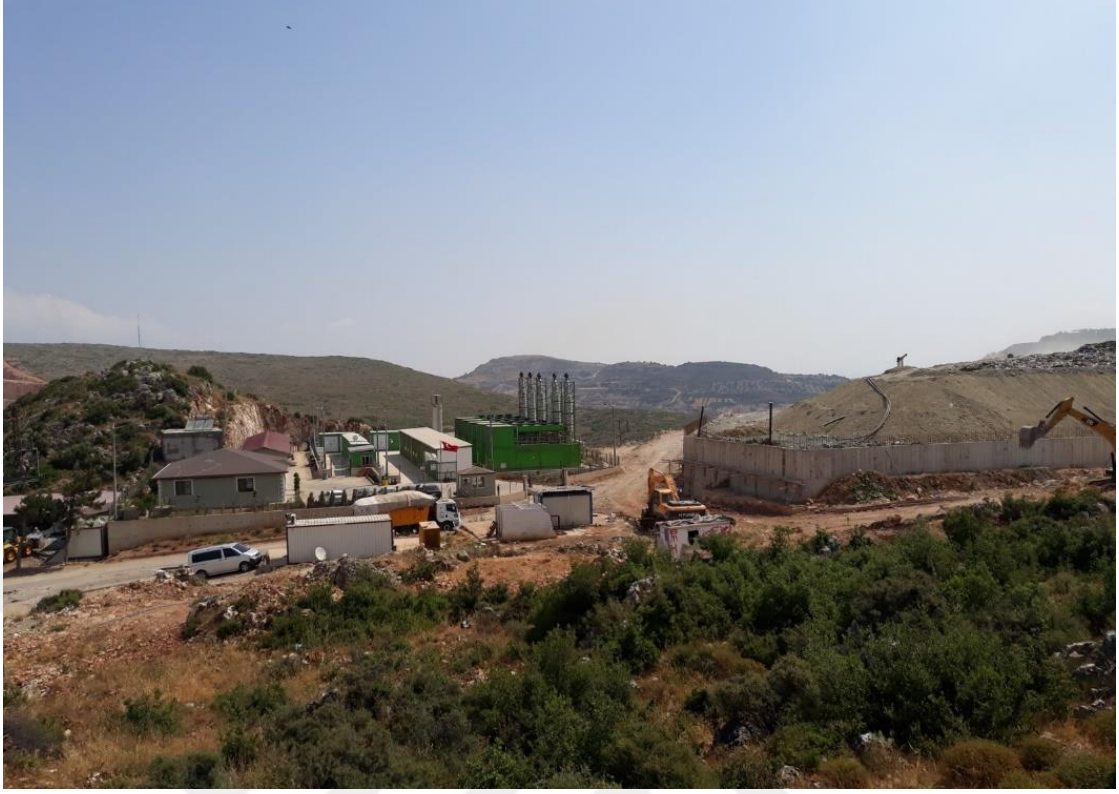
Şekil 3.2. Gökçeğöz katı atık düzenli depolama sahası
