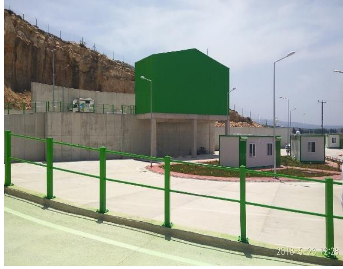
Şekil 4.8. Reyhanlı katı atık aktarma istasyonu
