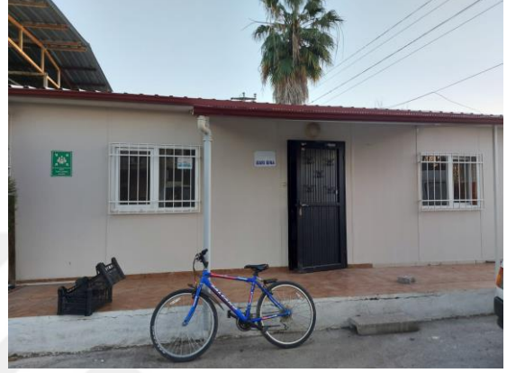
b) Yönetim binası
