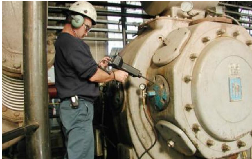
Şekil 3.12. Buhar kapağının ultrasonik testi (Anonim, 2014-f)
