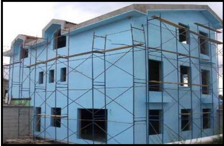
Şekil 1.1. Isı yalıtımı yapılmış konut (Anonim, 2012a)
