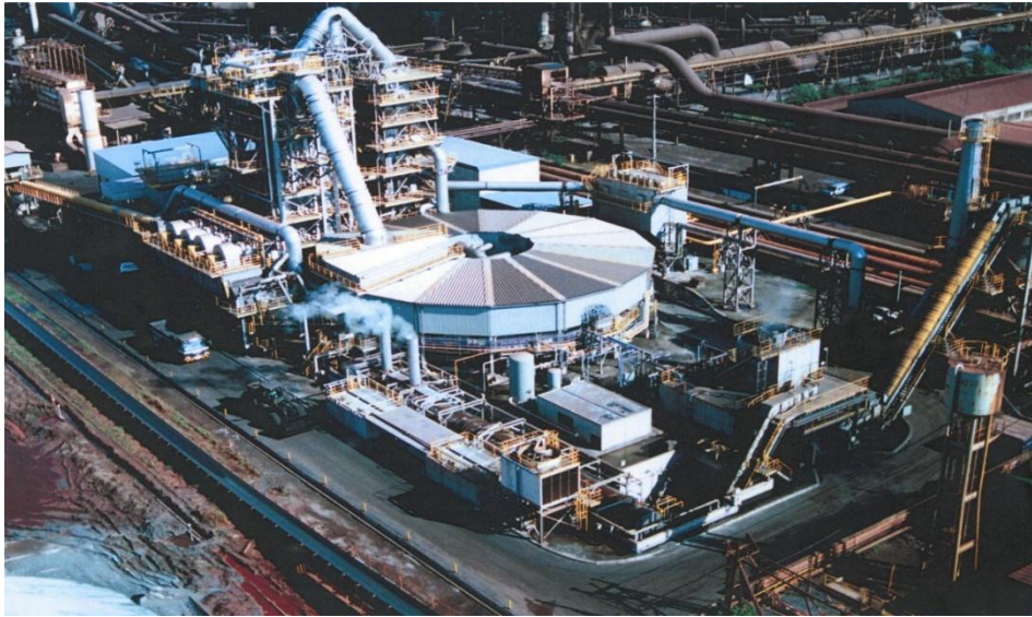
Şekil 4.6. Nippon Steel Döner Tabanlı Ocak (DTO) Fastmet teknolojisi
