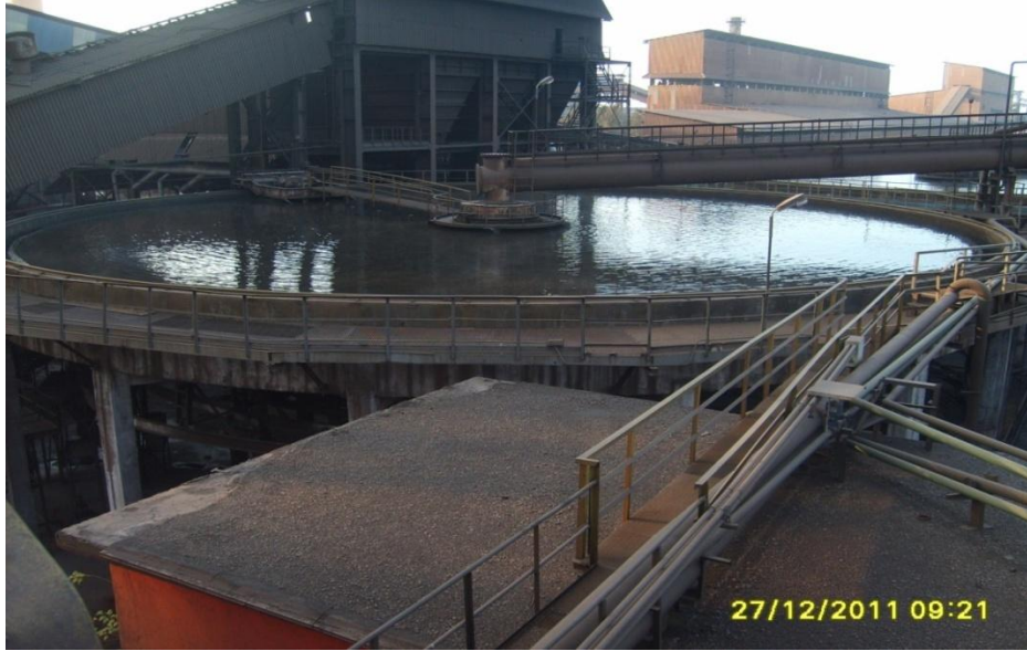
Şekil 3.2. Çamur hazırlama ve kurutma ünitesi çökeltme havuzları (İsdemir, 2011)
