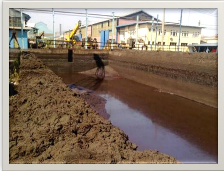
Şekil 2.5. Tufal sahası görünümü (Erdemir, 2012)
