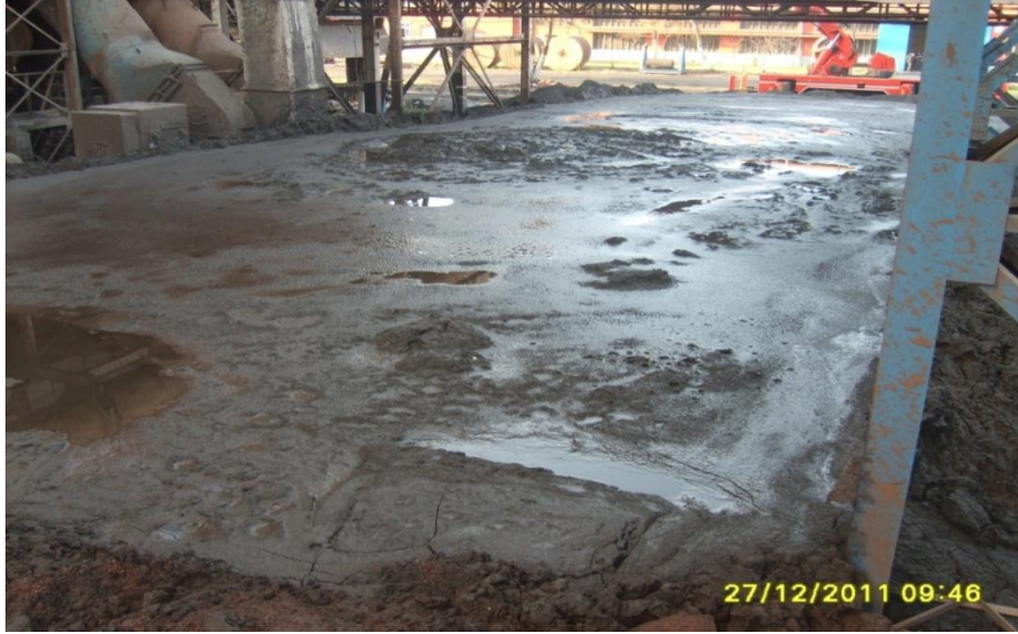
Şekil 3.8. İsdemir Çamur hazırlama ve kurutma ünitesi kurutma sahası (İsdemir, 2011)
