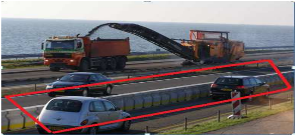
Şekil 1.10. Yol çalışması olan bölgelerde güvenli trafik akışı için şerit yaratma
