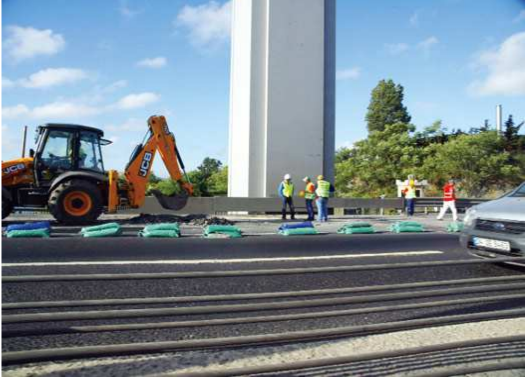
Şekil 1.19. Fatih Sultan Mehmet Köprüsü yol bakım çalışmaları
