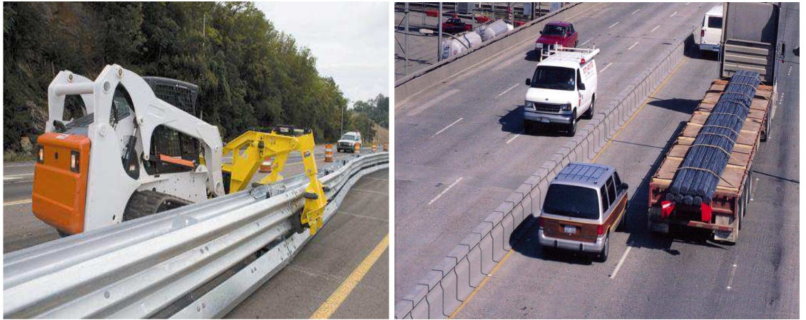
Şekil 1.8. Çelik ve beton hareketli otokorkuluk
