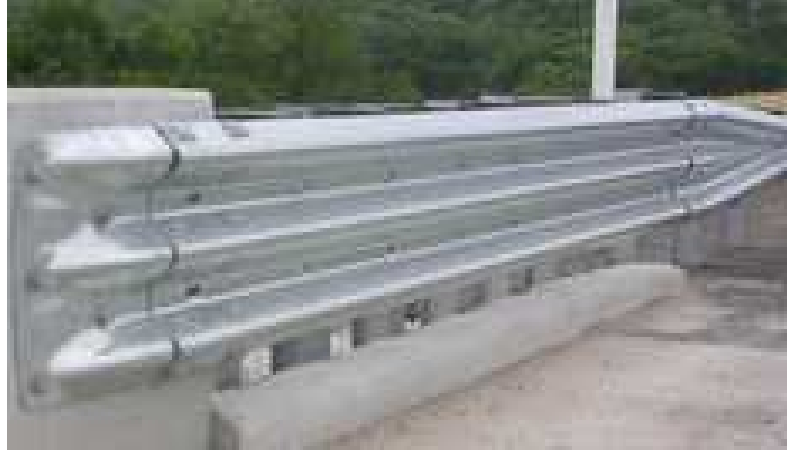
Şekil 1.6. Ağır hizmet tipi otokorkuluk
