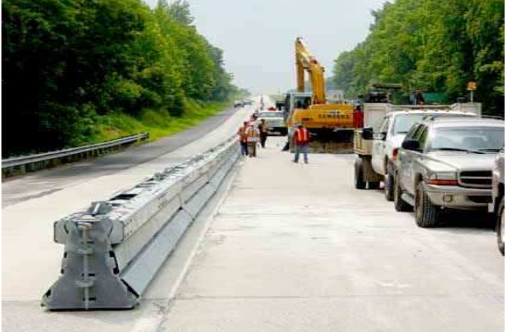
Şekil 1.11. İnşaat uygulamalarında kullanılan çelik hareketli otokorkuluk
