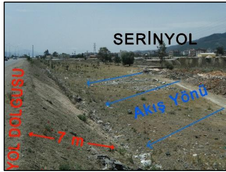
Foto 3. Çalışma Alanında Yelpaze Foto 4. Bedirge Kanalındaki Rüsubat ve Yüzeyinin 7 m Üzerine Kadar Yükselen ve Katı Atık Birikimi ile Arka Planda Kanal Akış Yönüne Dik Uzanan Yol Dolgusu Kapasitesini Düşüren Köprü Ayakları
