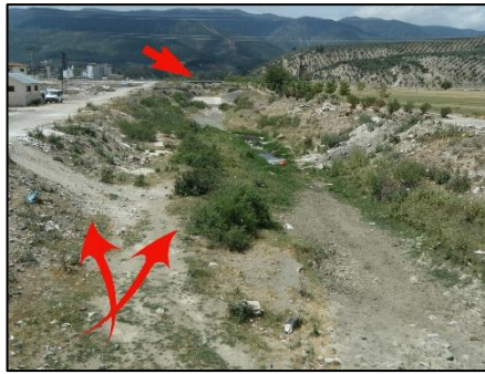
Foto 3. Çalışma Alanında Yelpaze Foto 4. Bedirge Kanalındaki Rüsubat ve Yüzeyinin 7 m Üzerine Kadar Yükselen ve Katı Atık Birikimi ile Arka Planda Kanal Akış Yönüne Dik Uzanan Yol Dolgusu Kapasitesini Düşüren Köprü Ayakları
