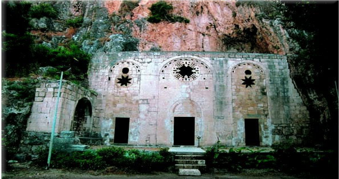
St. Piyer Kilisesi (Bugünkü durumu)
