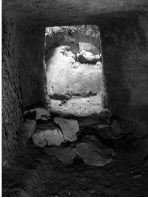
Resim 31: Sarnıç 15'in İç Kısımındaki Kanaldan Detay Görünüm
