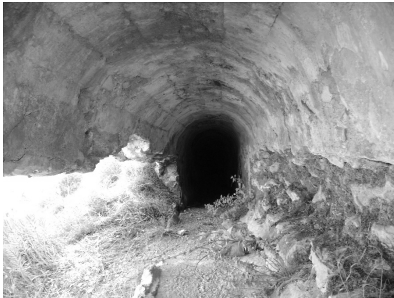
Resim 54: Örgü Kanal 1'in İçten Görünümü
