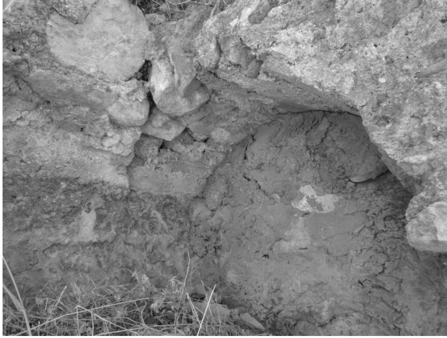
Resim 73: Örgü Kanal 14'den Detay Görünüm
