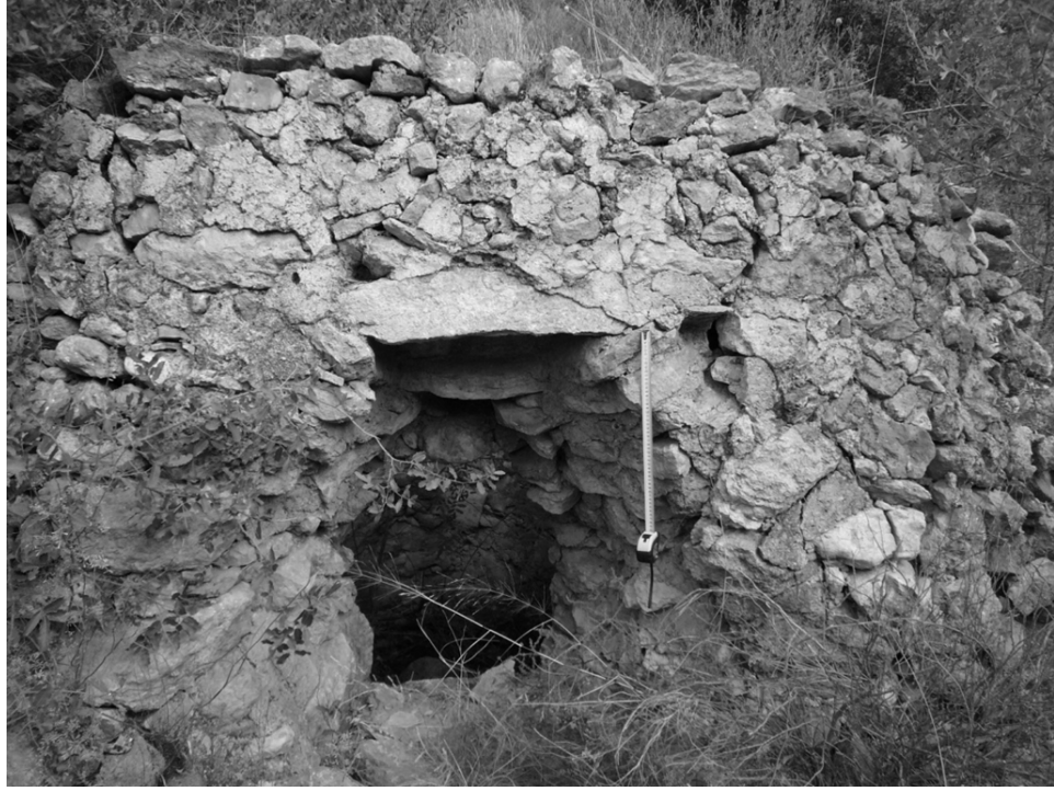
Resim 59: Örgü Kanal 4 İle Bağlantılı Depo Yapısı
