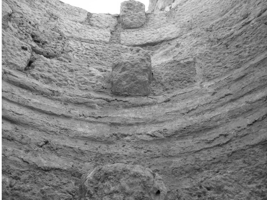
Resim 34: Sarnıç 17'den Duvar Örgüsü Detayı
