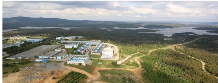
Şekil 1.7. İski Ömerli içme suyu arıtma tesisi (Anonim, 2023f)
